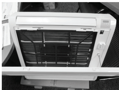
Figure 7. Retrait typique du filtre MFMA
